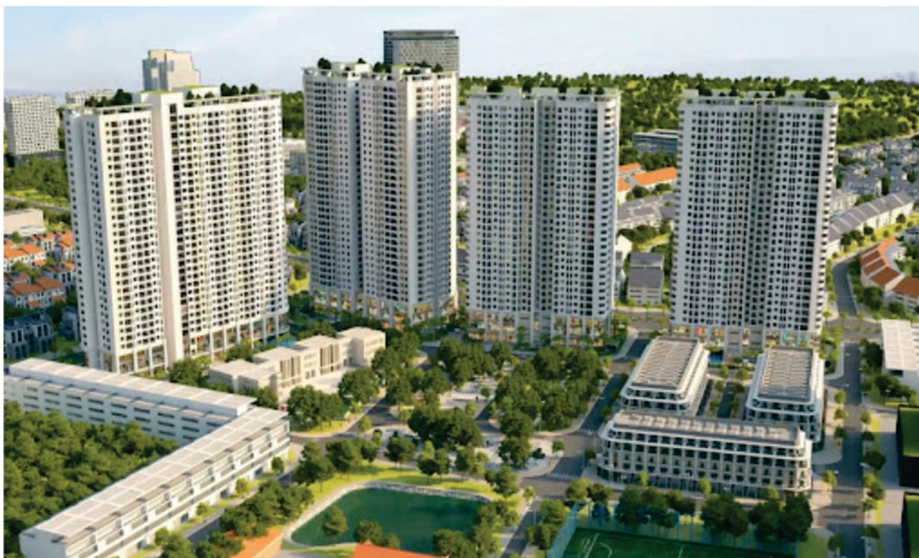
Kiểm định kỹ thuật an toàn Thang máy tại DỰ ÁN CIPUTRA – DỰ ÁN GELEXIA HOÀNG MAI
