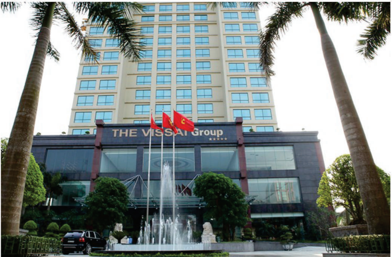
Đào tạo giáo dục nghề nghiệp Vận hành xe nâng, tời cầu trục, áp lực, tại các nhà máy TẬP ĐOÀN XI MĂNG THE VISSAI
