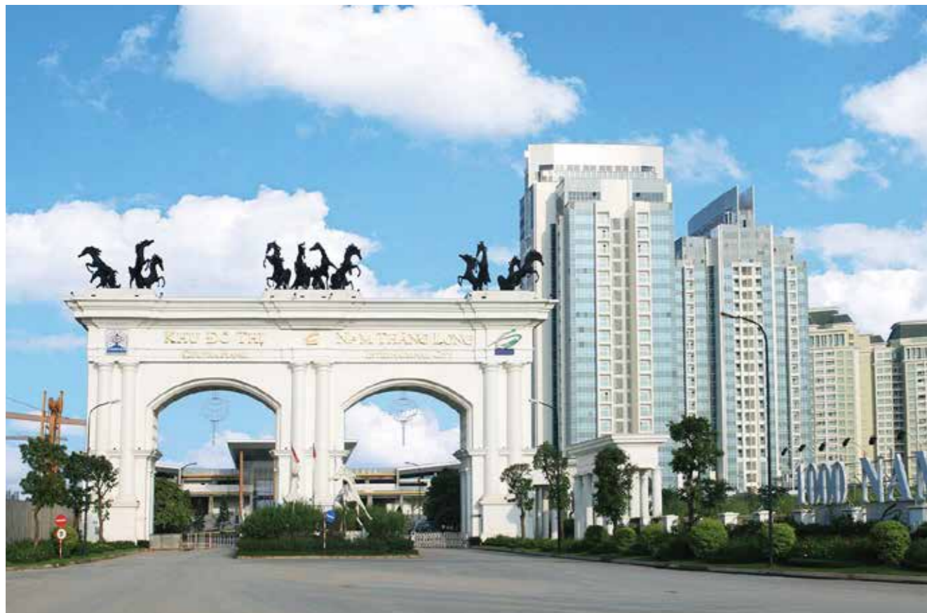
Kiểm định kỹ thuật an toàn Thang máy tại Dự án Ciputra Thăng Long
