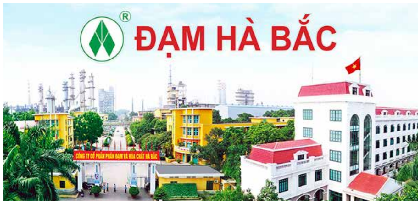
CÔNG TY CỔ PHẦN PHÂN ĐẠM VÀ HÓA CHẤT HÀ BẮC Công việc: Kiểm định thiết bị yêu cầu nghiêm ngặt.
