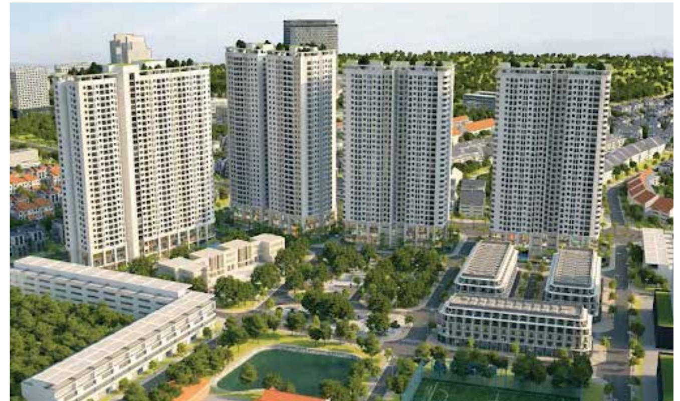
Kiểm định kỹ thuật an toàn Thang máy tại DỰ ÁN CIPUTRA – DỰ ÁN GELEXIA HOÀNG MAI
